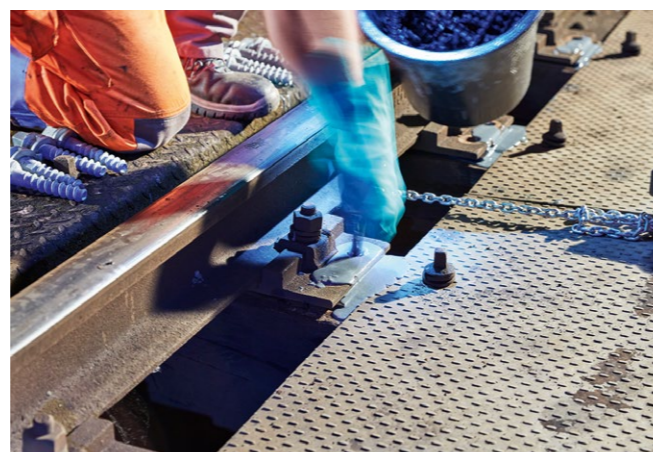
▲ Reinigen der Bohrlöcher
