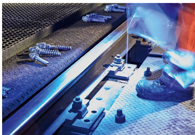
▲ Einsetzen von Spurstangen
